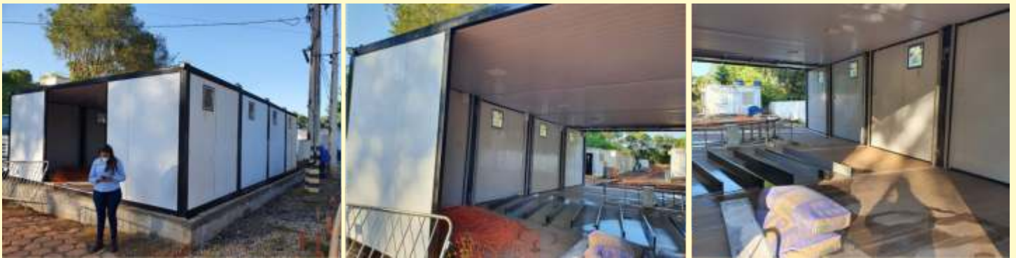
Containers já estão sendo instalados para evitar aglomeração dos trabalhadores no vestiário
